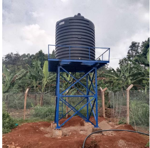
De watertoren voorziet in irrigatie
