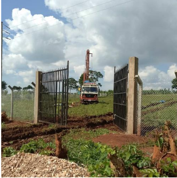
Water aangeboord op 80 meter diepte
