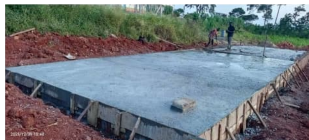
Het fundament is gelegd
